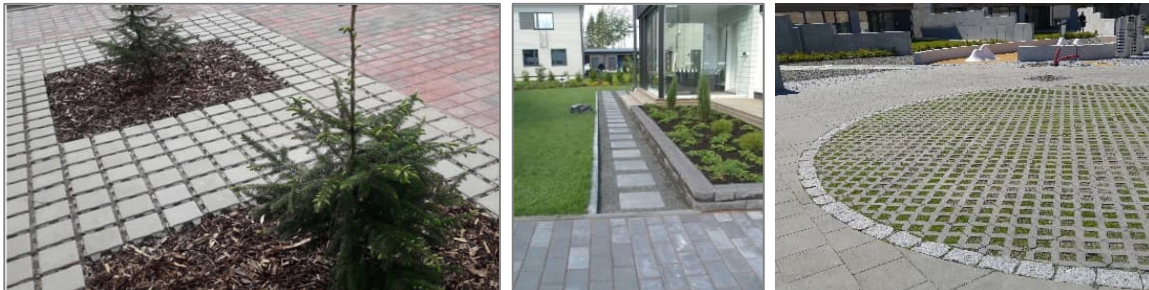
Kuva 10. Nurmikiviä sekä laatan ja sorapinnan yhdistämistä. Kuvat vasemmalta: Pihakivi.com, RudusPiha, Eija Toivonen.
